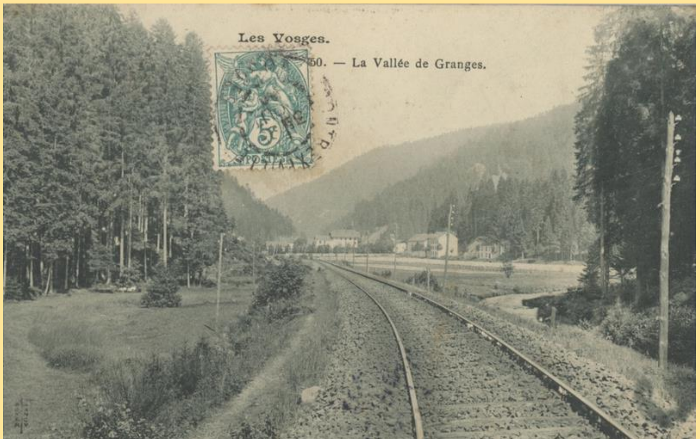
Voie ferrée à Granges
