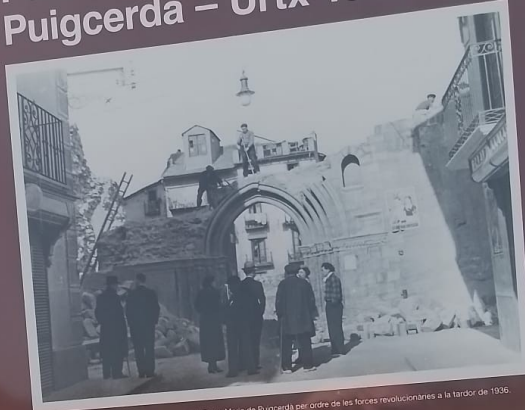
Destrucció a pic i pala de l'església parroquial de Santa Maria de Puigcerdà per ordre de les forces revolucionàries a la tardor de 1936. Arxiu Comarcal de la Cerdanya, Fons Salvador Gaberán Vique, 0204.
